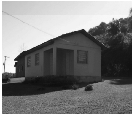
Figura 7: Prédio da Escola Municipal de Ensino Fundamental Olavo Bilac
