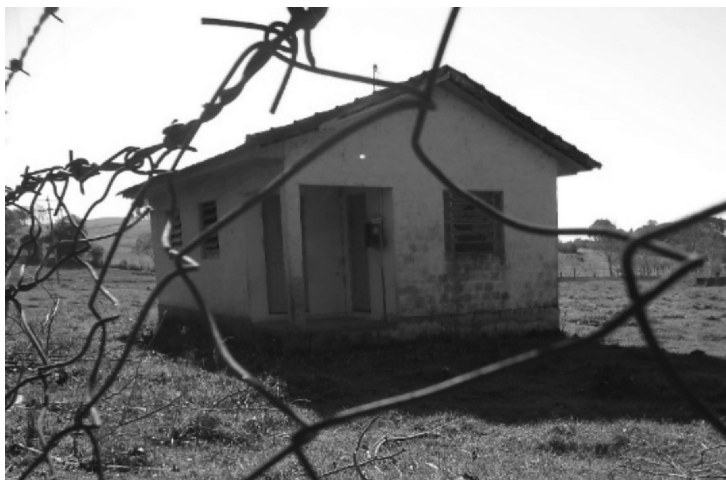
Figura 3: Prédio da Escola Municipal de Ensino Fundamental Carlos Frederico Otto Heidemann
