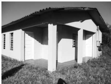
Figura 6: Prédio da Escola Municipal de Ensino Fundamental Generino Bernardi
